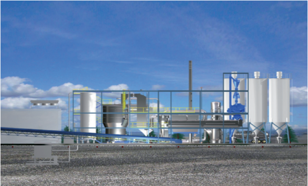
Düngerturm, vertikale Anordnung
