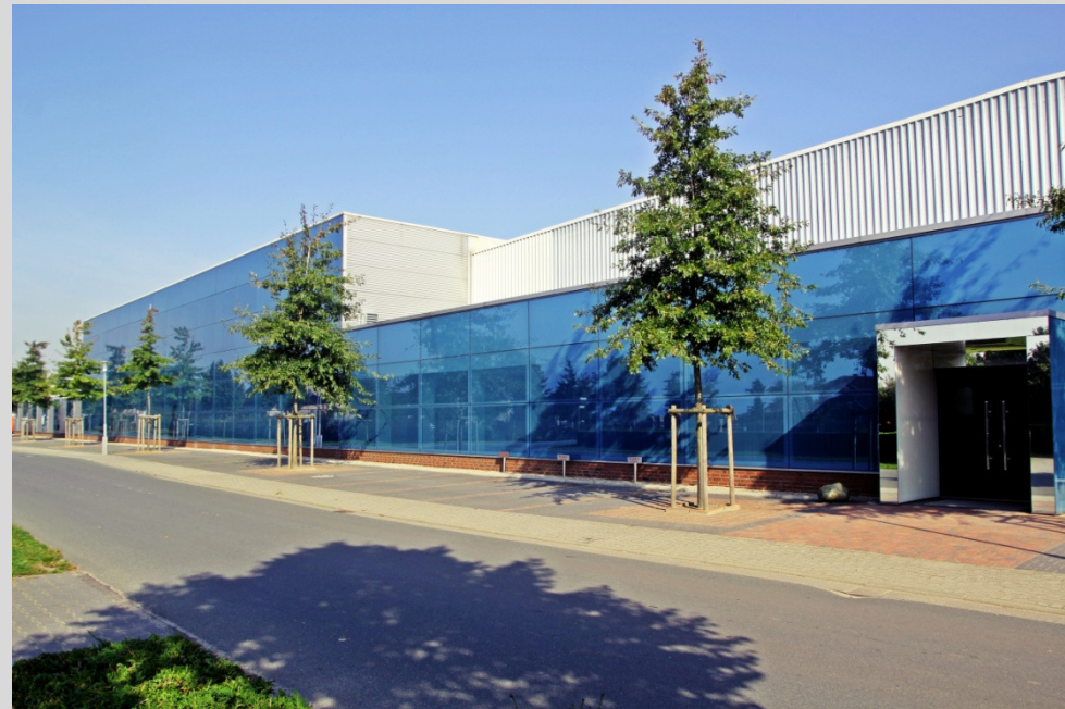
Frontansicht Hero-Glas Gebäude
