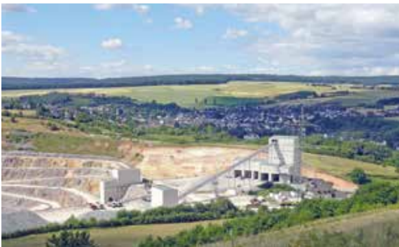
Aufbereitungsanlage mit optischer Sortierung
